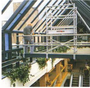
Passarellen können auf Rollen montiert werden, um mobile Zugangsbrücken zu errichten.
