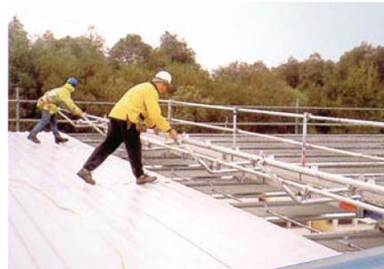
Der Leichtbau-Nachlaufkantenschutzrahmen ermöglicht sichere und einfache Beweglichkeit.
