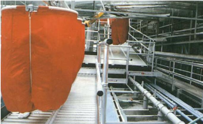
Verdoppelter **SPANDECK**-Laufsteg in einer Industrieräscherei, ermöglicht den Zugang zum Transportsystem und verhindert, dass Fremdkörper nach unten in die Maschine fallen.
