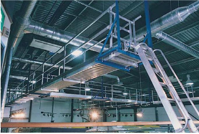
Feste Installation einer **SPANDECK** Hänge-Brücke im Royal Signals Museum, gewährleistet Zugang zu Arbeitsplätzen im Dachbereich, wie beispielsweise zur Klimaanlage, ohne, dass die Ausstellung für die Öffentlichkeit geschlossen werden muss.
